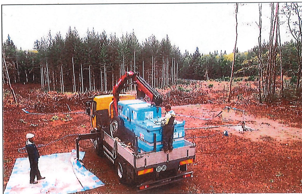
Installation des tubes guides le long de la colonne d'exhaure pour le passage des sondes
