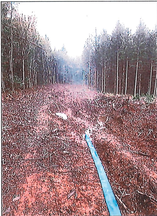
Rejet des eaux exhaurées à 55 m en aval hydraulique du pompage
