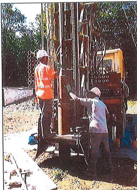
Tubage acier en \varnothing 273 mm installé jusqu'à 4 m de profondeur
