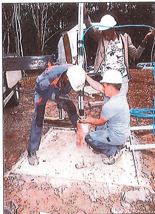
Installation des tubes guides le long de la colonne d'exhaure pour le passage des sondes
